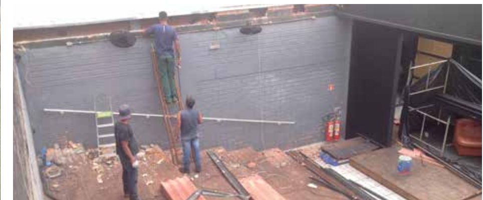
O telhado foi trocado em todo imóvel. Aqui imagem do teatro sendo reformado (Marlon Marques)
